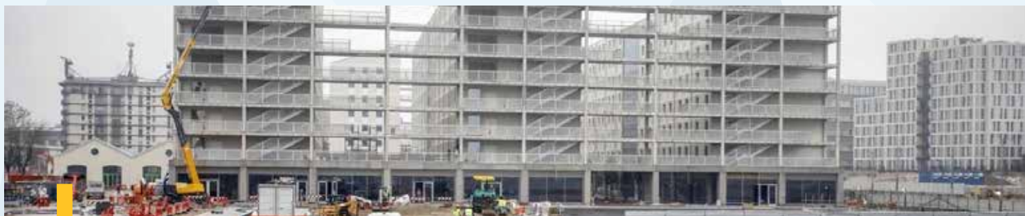
PALAZZINE DEL VILLAGGIO OLIMPICO EX SCALO PORTA ROMANA
